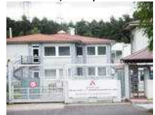
Bränsleelement till Oskarshamns kärnkraftverk ska tillverkas här i Arevas anläggning utanför den tyska staden Lingen. Foto: Fredrik Loberg
