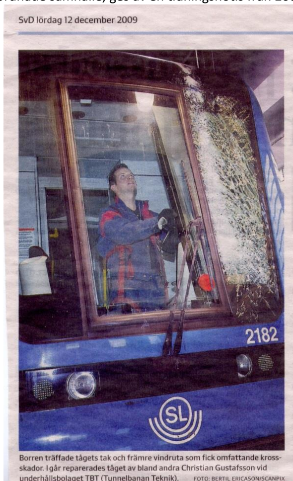
Figur 19. Bergvärmeborr som gått igenom taket till tunnelbanan i Stockholm.
